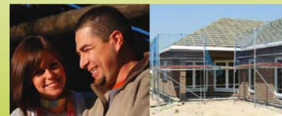
bij uw huis in aanbouw
